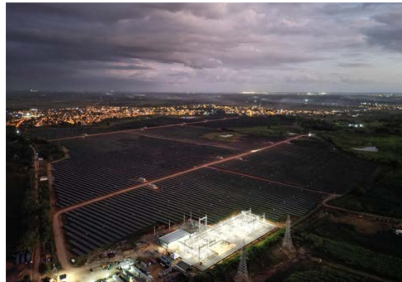
PLANTA FOTOVOLTAICA MIRASOL 127 MW , SUBESTACIÓN Y LÍNEA DE TRANSMISIÓN (REPÚBLICA DOMINICANA)
