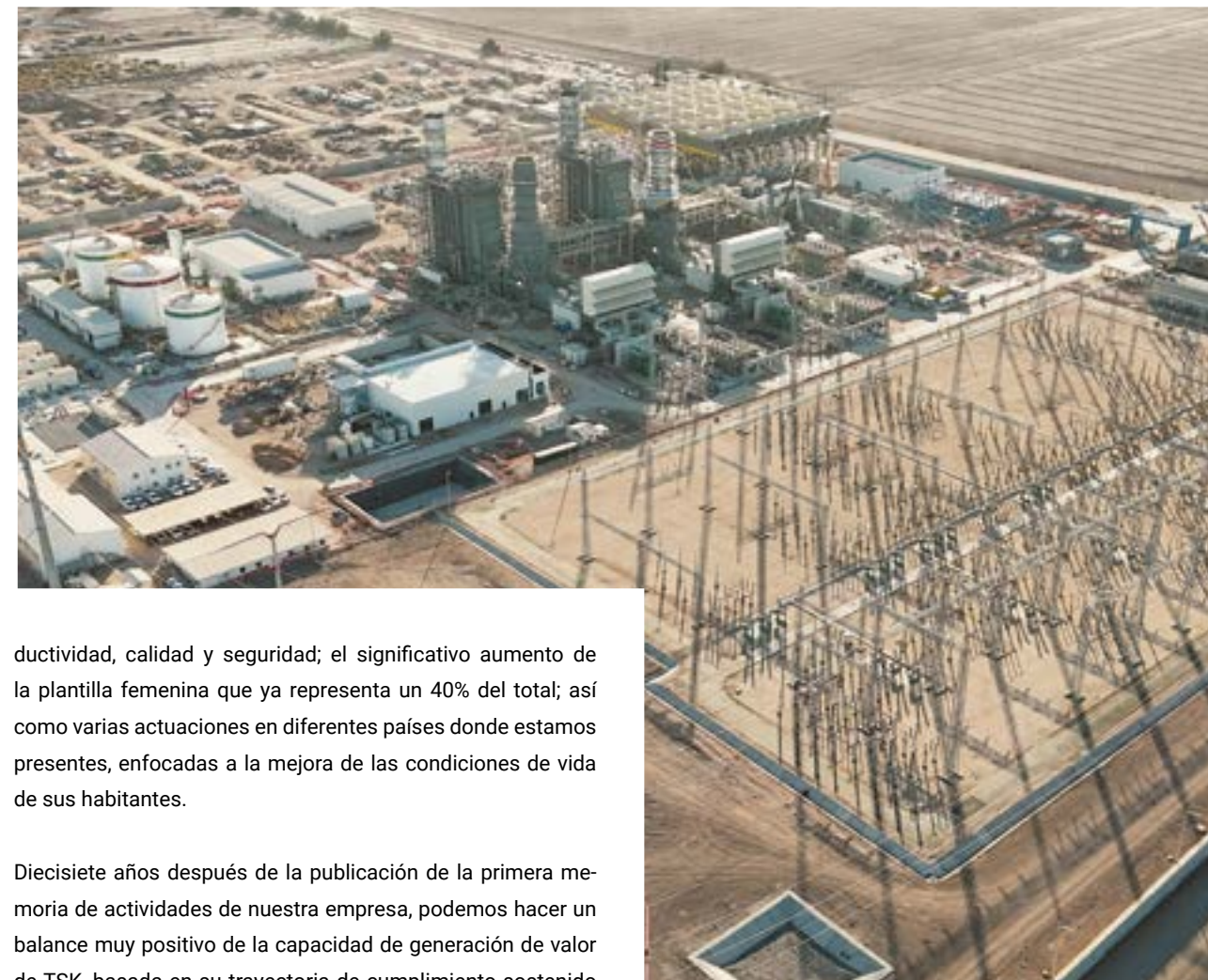
CENTRAL CICLO COMBINADO GONZÁLEZ ORTEGA 641 MW (MÉXICO)
