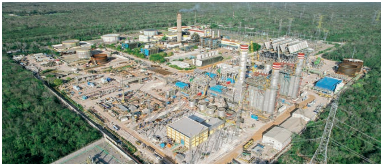
CENTRAL CICLO COMBINADO VALLADOLID 1000 MW+ SUBESTACION 400 KV (MÉXICO)
