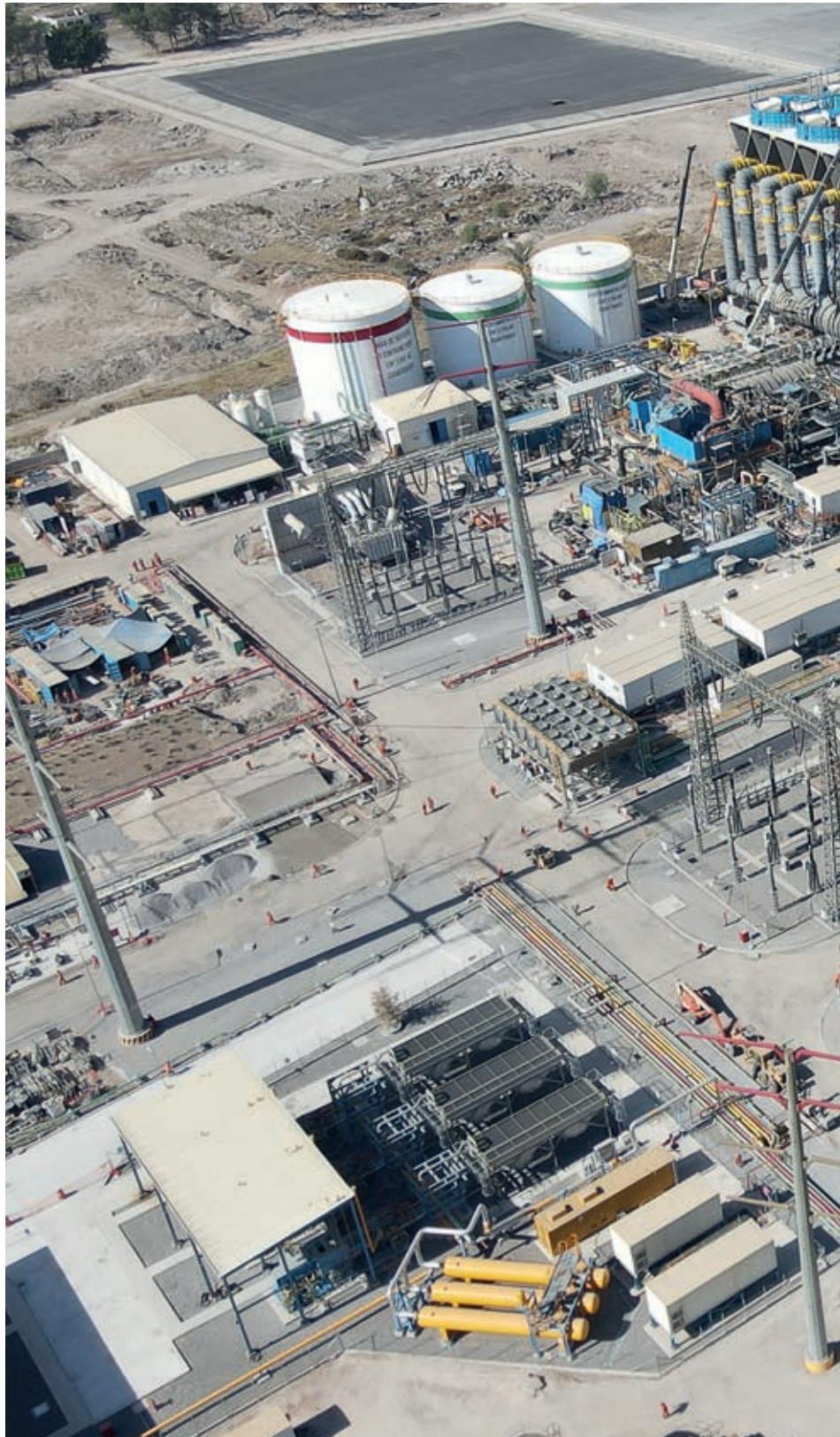
CENTRAL CICLO COMBINADO SALAMANCA 950 MW + SUBESTACIÓN 400 KV Y LT (MÉXICO)
