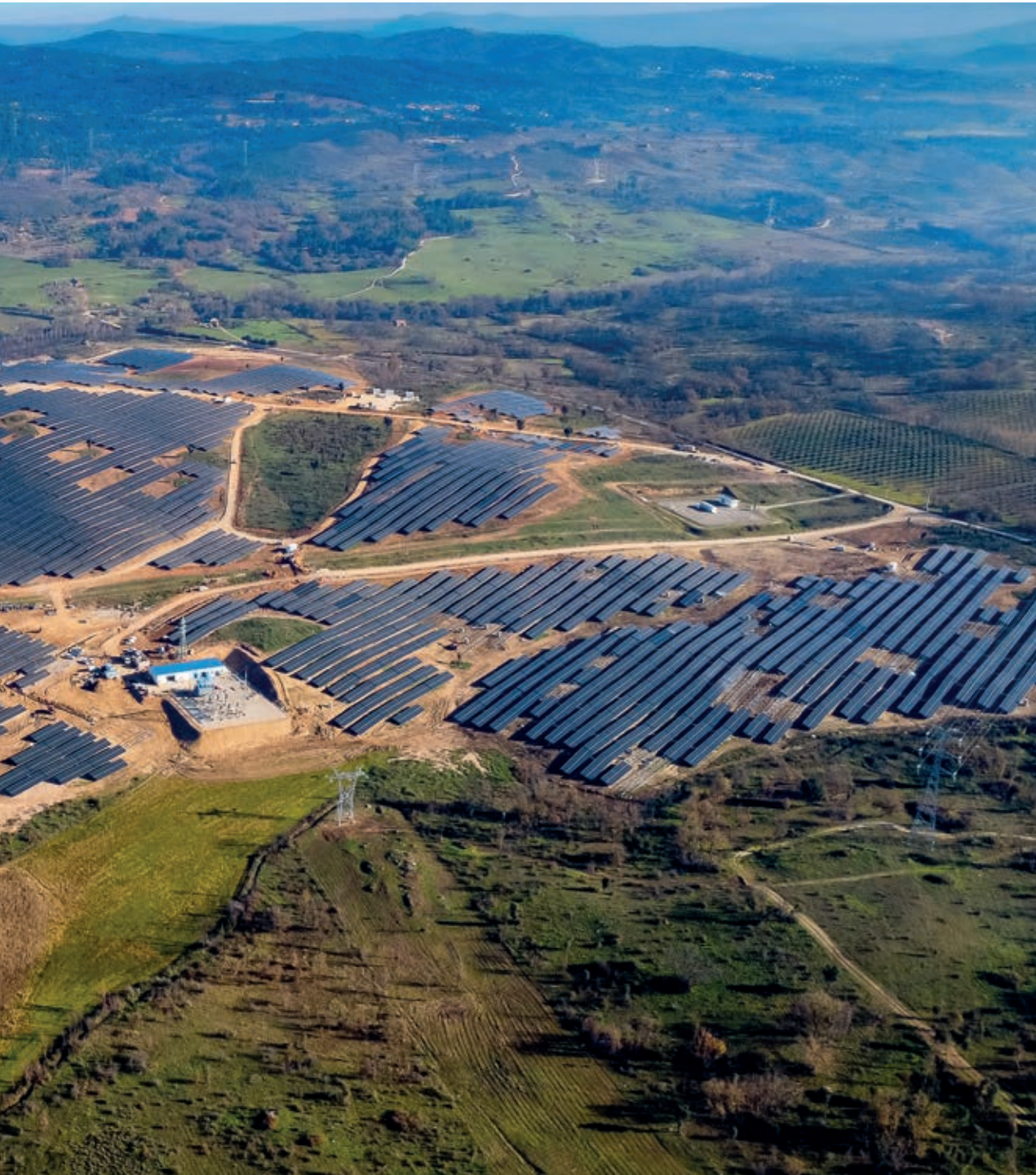
PLANTA FOTOVOLTAICA FUNDÃO 126.5 MW + SUBESTACIÓN Y LT 220 KV (PORTUGAL)
