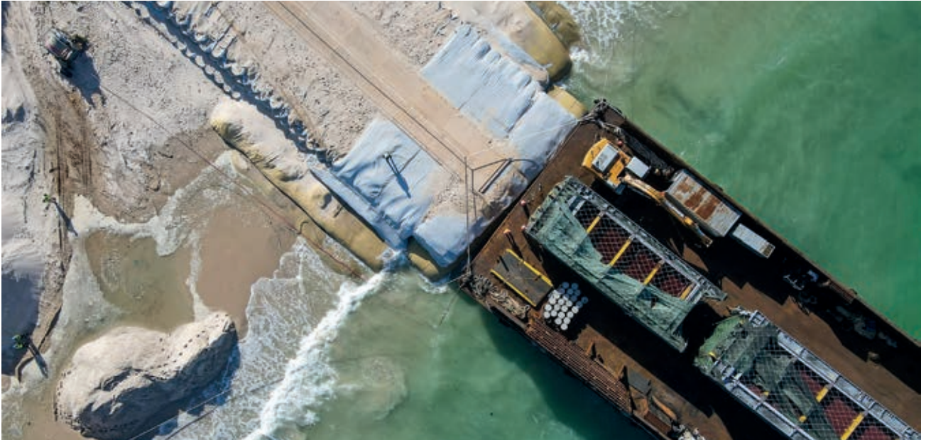
JETTY PARA ABASTECIMIENTO MARÍTIMO PARA LA CONSTRUCCIÓN DE LA CENTRAL DE CICLO COMBINADO DE TEMANE (MOZAMBIQUE)
