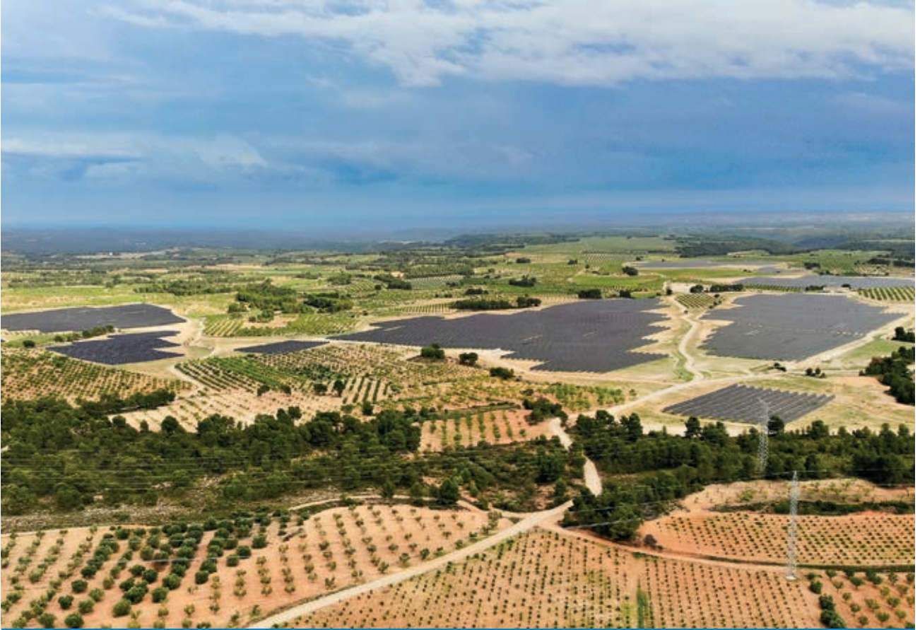
COMPLEJO SOLAR MINGLANILLA 100 MW + SUBESTACIÓN Y LT 132 KV (ESPAÑA)
