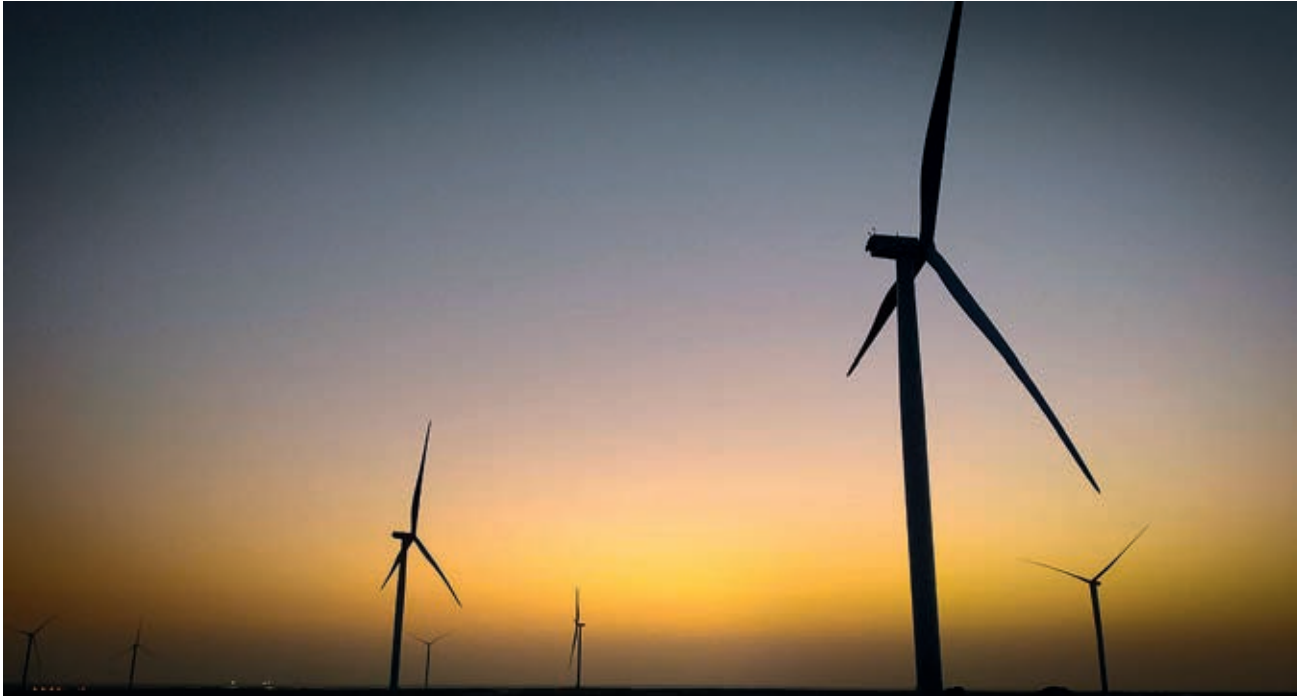
PARQUE EÓLICO DHOFAR 50 MW Y SUBESTACIÓN 132 KV (OMÁN)
