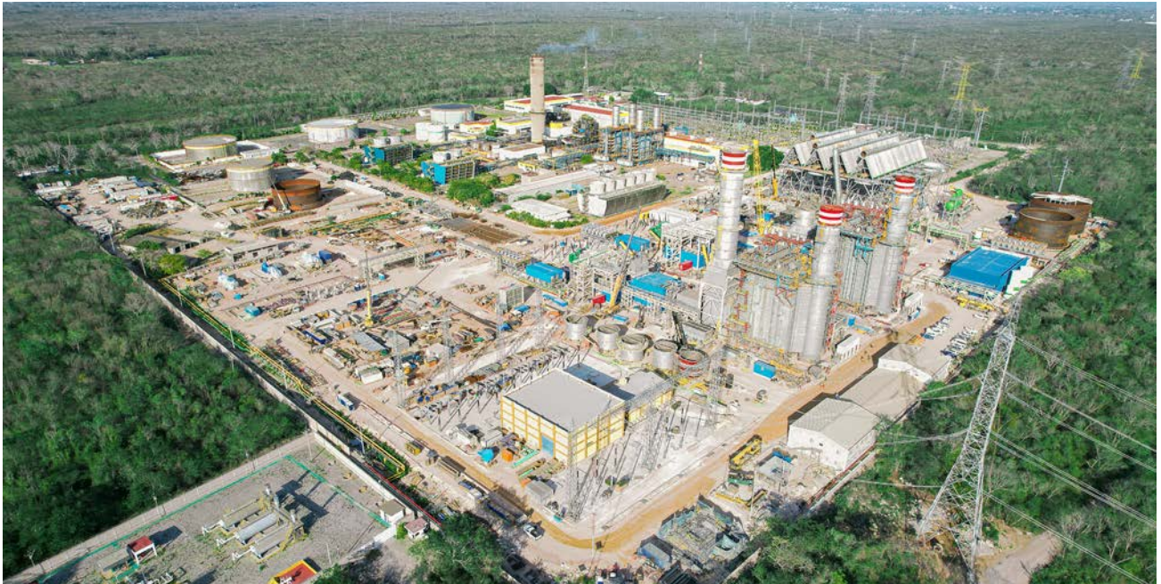
VALLADOLID 1000 MW CCGT + 400 KV SUBSTATION (MEXICO)
