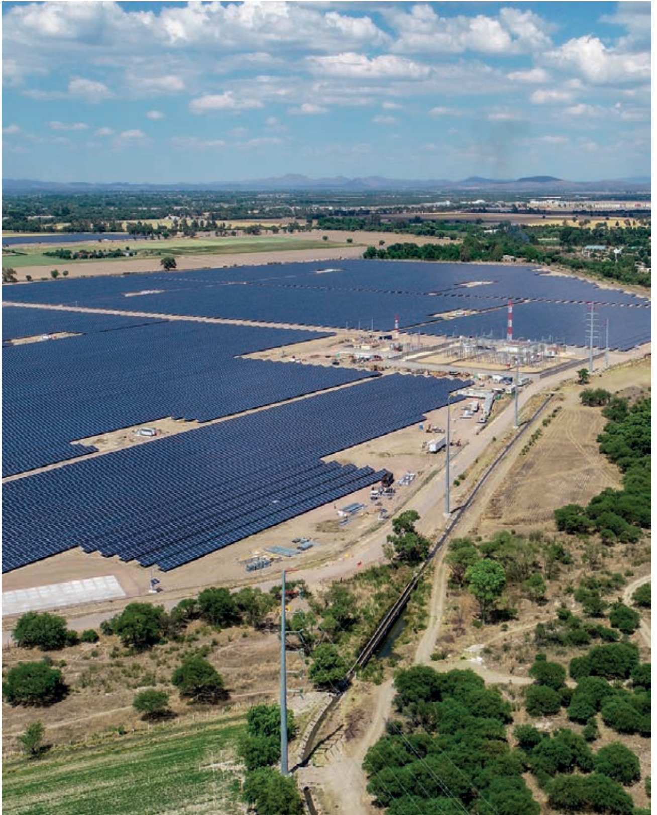
Plantas fotovoltaicas Las Animas II y Versalles de las Quatas, Subestaciones y Línea de transmisión. Durango (México)
