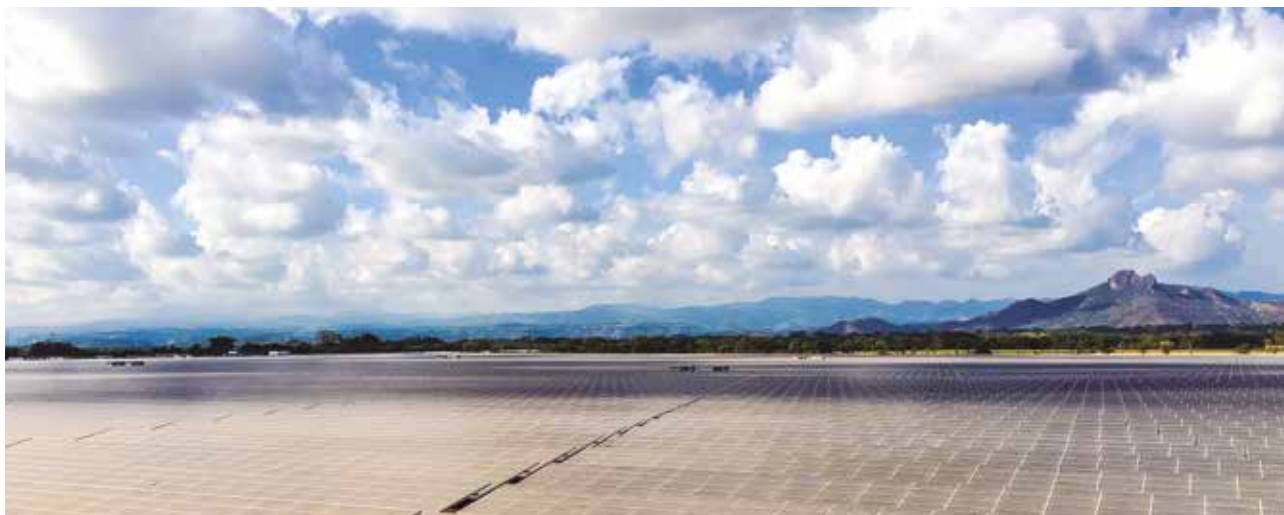
Providencia Solar. 100 MW PV Plant. (El Salvador)
