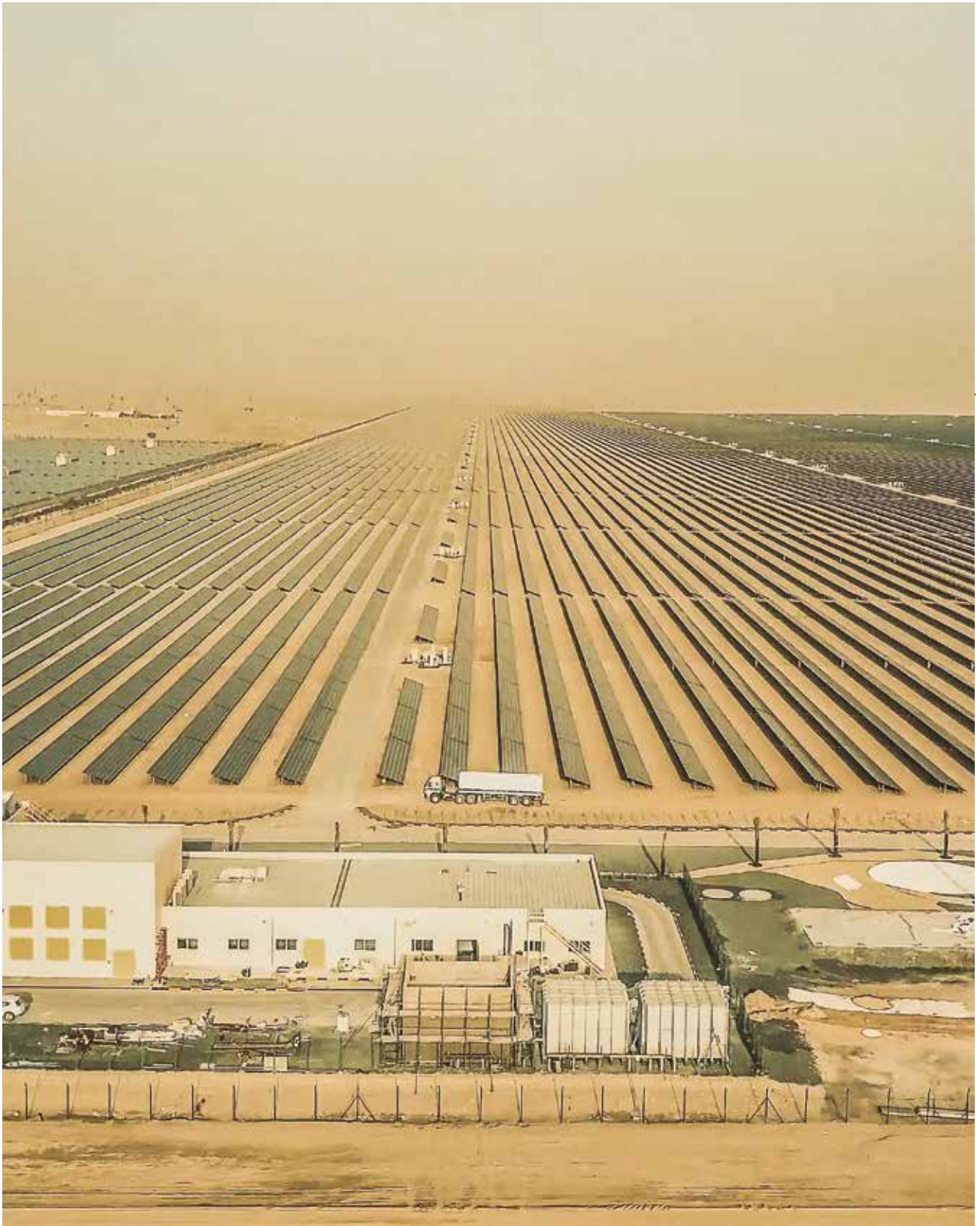
MBR Al Maktoum Solar Park. 260 MW PV Plant. Dubai (UAE)
