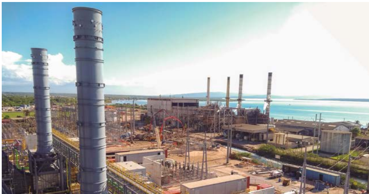
Old Harbour Bay II. Central Ciclo Combinado 190 MW (Jamaica)
