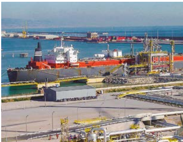
Interconexión de ORMAT con las instalaciones de la terminal de GNL de Huelva.
