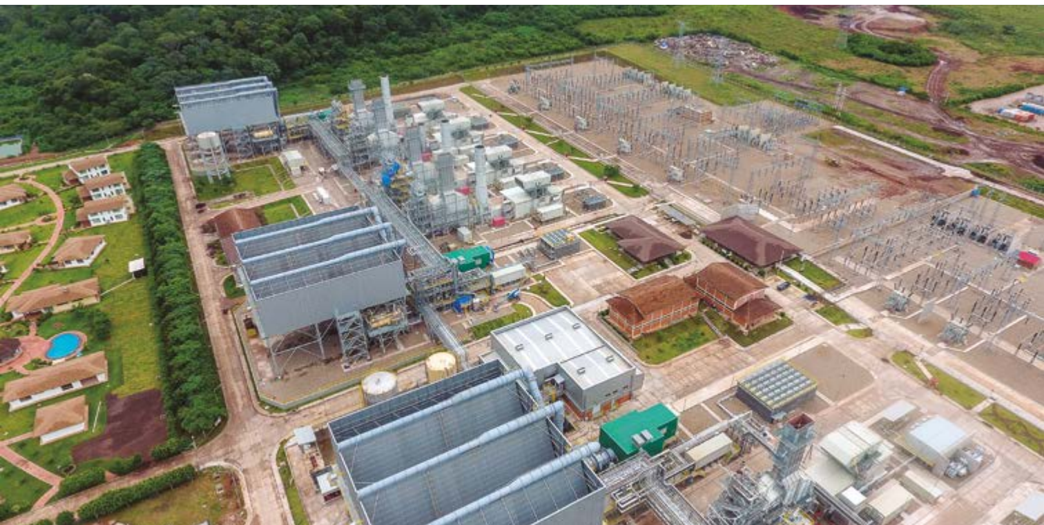
Termoelectrica del Sur. Central Ciclo Combinado 295 MW + Cierre de Ciclo 80 MW. (Bolivia)
