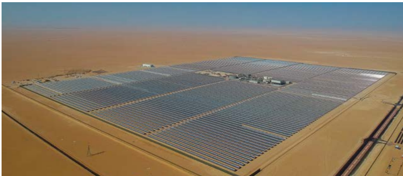
Central termosolar 50 MW con almacenamiento térmico. Shagaya Renewable Energy Park (Kuwait)
